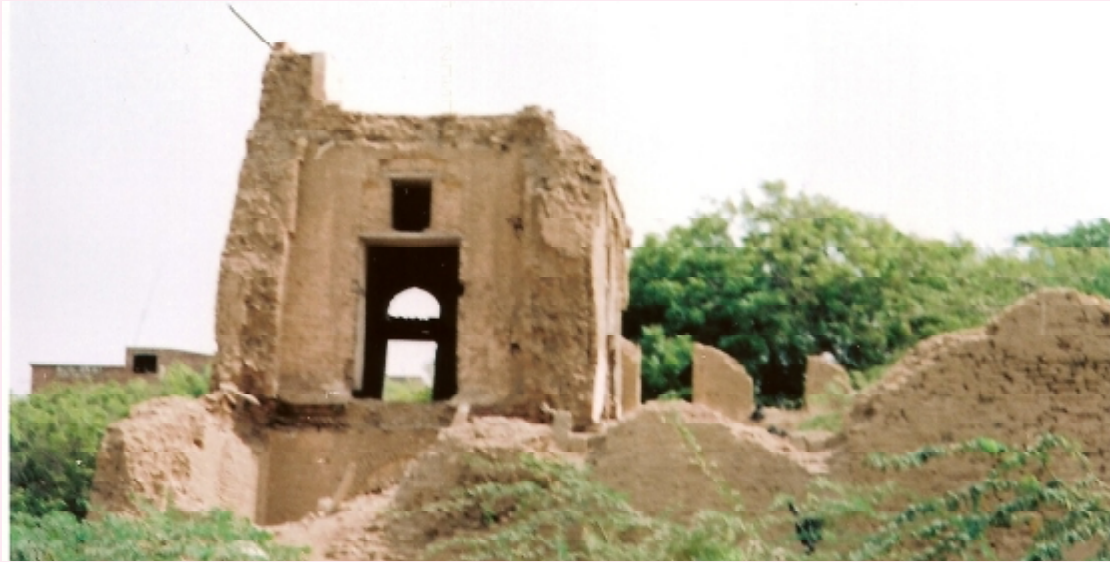
شكل (١٣): أحد المباني القديمة المهجورة والمبنية بالطين
