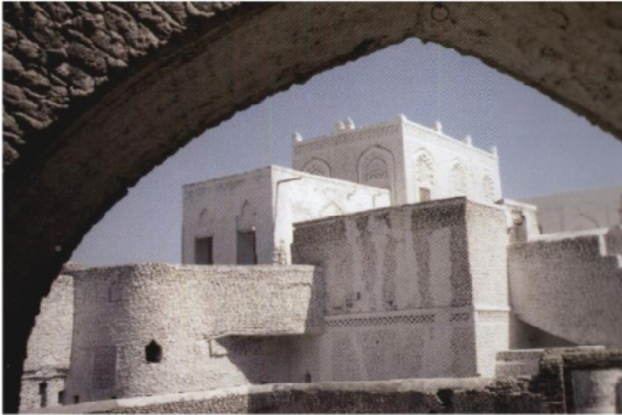
مثال حي من عمارة المنطقة الساحلية الغربية (زبيد) وهو يبين كيف استخدم المعمار المحلي الكتل والنون للتخفيف من حرارة الشمس التي يتعرض لها المبنى.
