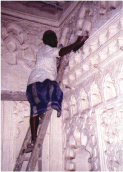
استخدام النورة في عمل التكسيات والزخارف الداخلية، كما تستخدم لتكسية الواجهات
