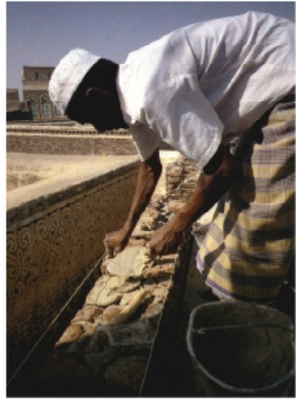
صورة توضح الطريقة التقليدية لبناء مدمالك الياجور ويكون غالباً بعرض (٢٤) سم.
