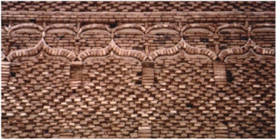
الطين المحروق أو الياجور (١٧×١٧×٦) سم هي مادة البناء الرئيسية في مباني المنطقة الغربية، وهي الوحدة الأساسية للأشكال الزخرفية التي تتميز بها عمارة المنطقة.
